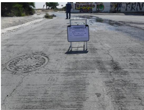
Fisuramientos por retracción en la avenida Las Villas.
